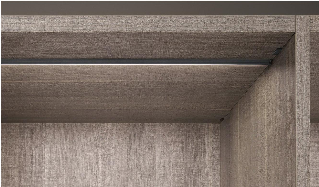
L'inserimento di lampade a LED solo nel coperchio non prevede un canale verticale. Senza canale verticale è esclusa la possibilità di successivo inserimento di lampade a LED nelle mensole.
